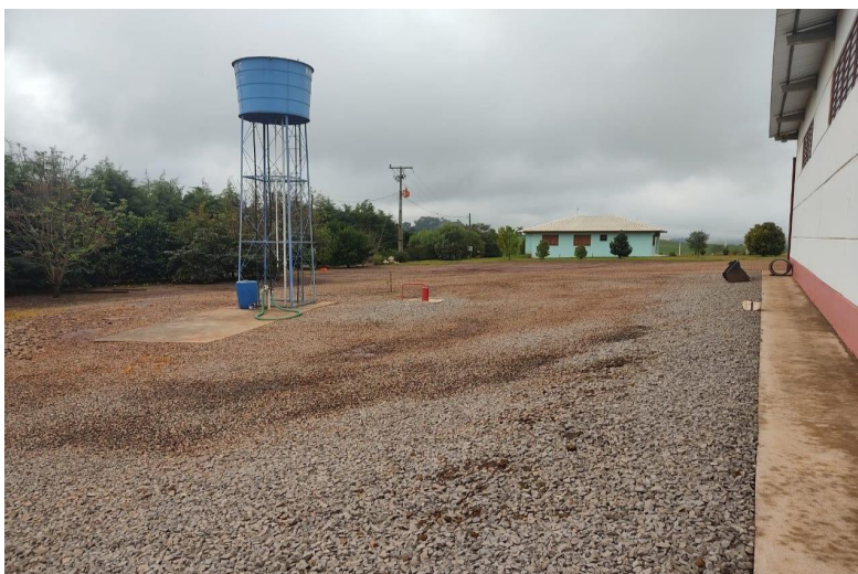
Figura 6: Local de construção do armazenamento de combustível.
