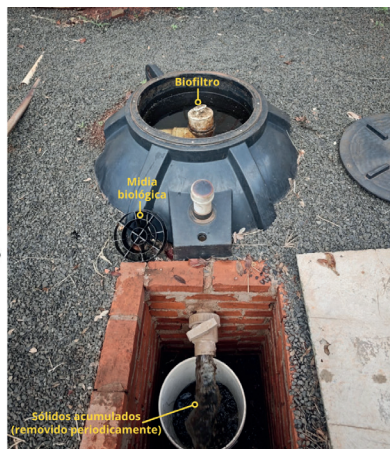
Figura 6 - Esquema de funcionamento do biofiltro utilizado na aquaponia do Setor de Piscicultura da ESALQ - USP
