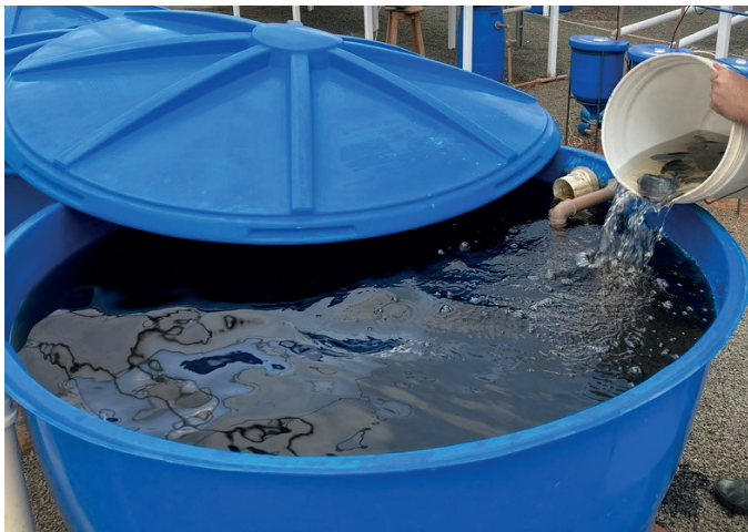
Figura 2 - Tanque do sistema de aquaponia do Setor de Piscicultura da ESALQ - USP, construído com caixa d'água
