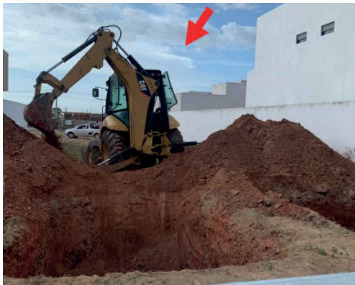
Figura 1. Retroescavadeira utilizada para a escavação da fossa séptica e sumidouro.
