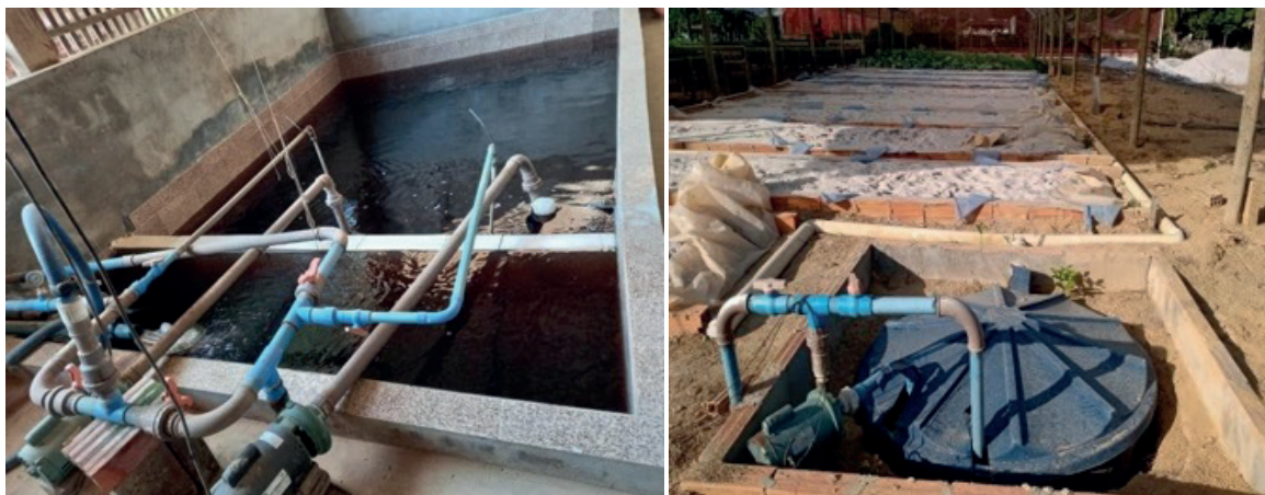
Figura 6. Motor-bomba da solução nutritiva dos sistemas hidropônico e semi-hidropônico.
