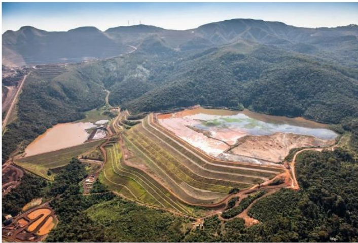
Figura 5 - Vista aérea da Barragem I - Mina Córrego do Feijão, Complexo Paraopeba - VALE S.A., Brumadinho/MG
