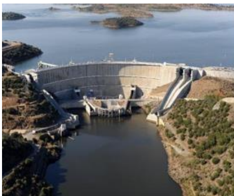
Barragem. Fonte: Efacec
