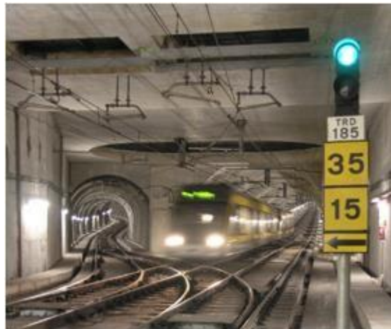
Sinalização de metro ligeiro. Fonte: Efacec
