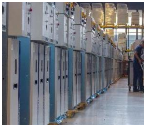
Aparelhagem de distribuição primária. Fonte: Efacec
