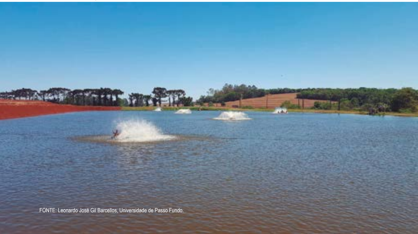
FIGURA 4.7 - Tanque escavado com aeradores acionados
