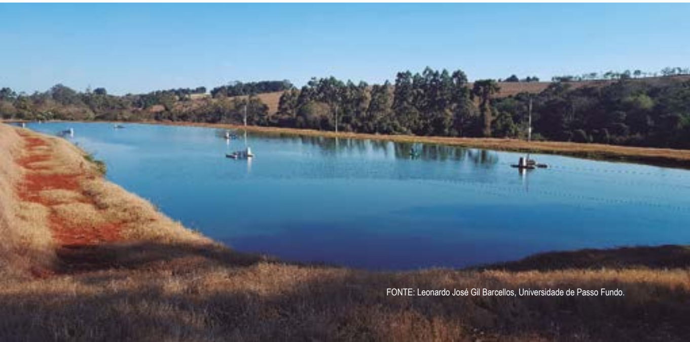
FIGURA 5.2 - Tanques escavados de grande tamanho
