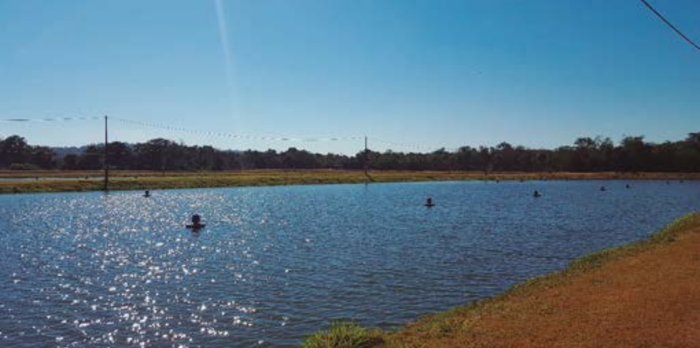
FIGURA 5.5 - Tanque escavado de formato regular retangular nas proporções 5:1
