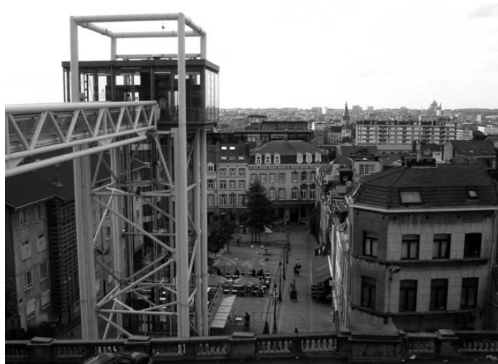
Figura 12.1: Elevador construído na região central de Bruxelas, Bélgica.
