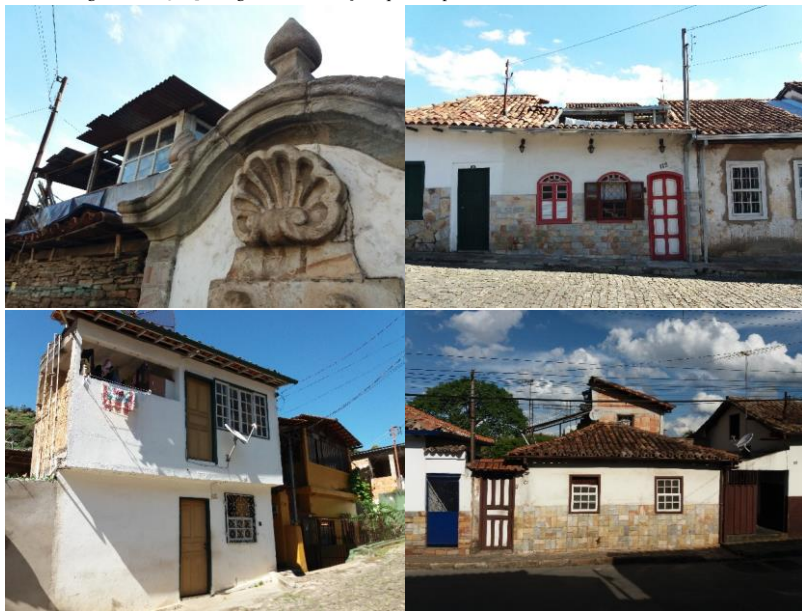
Figuras 6, 2, 3 e 4: Imagens das edificações que compõem o bairro Padre Faria em Ouro Preto
