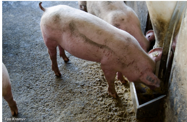
FIGURA 10. Piso desgastado no entorno do comedouro em decorrência do efeito corrosivo do alimento úmido fermentado.
