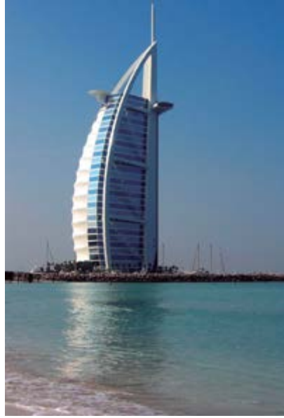
Figura 8.4: Burj-al-Arab Hotel, Dubai, Emirados Árabes Unidos, 2011.
