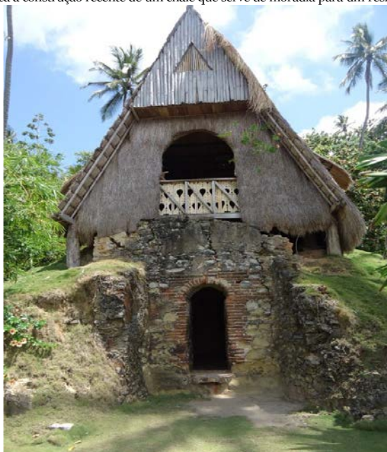
FIGURA II: Forno de Cal - Vila Velha. A estrutura deste forno é mais bem conservada. Pode-se observar acima da boca a construção recente de um chalé que serve de moradia para um residente da ilha.
