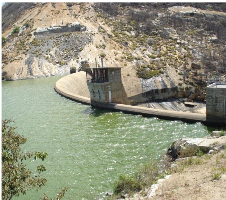
Figura 3.4 – Torre de abrigo das válvulas de controle da tomada de água do Açude Gargalheira, Acari/RN.
