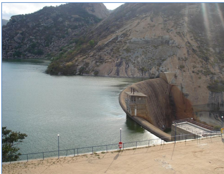
Figura 3.3 – Barramento em concreto ciclópico e ombreiras de apoio do Açude Gargalheira, Acari/RN
