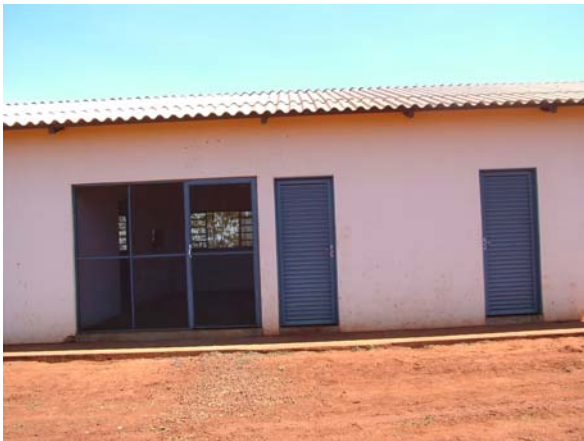
c) Local de apoio aos catadores de material reciclável
