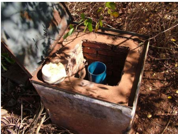
e) Poço de monitoramento de águas subterrâneas
