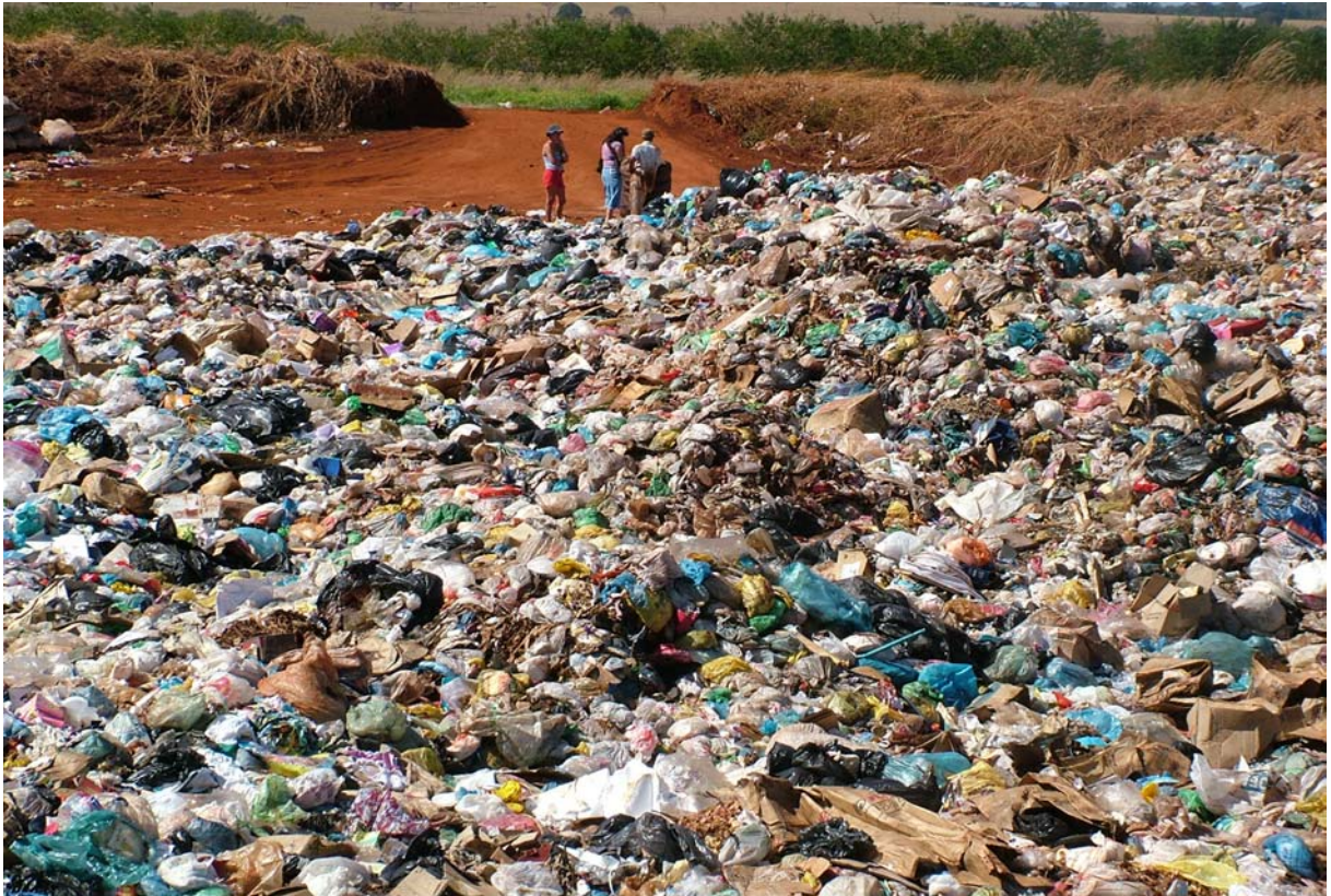
Ilustração 15 – Lixo depositado no aterro sem a compactação e recobrimento adequados (julho/2006)
