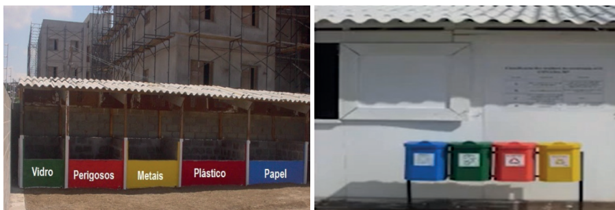
Figura 7 - Depósito temporário de resíduos no canteiro de obra.
